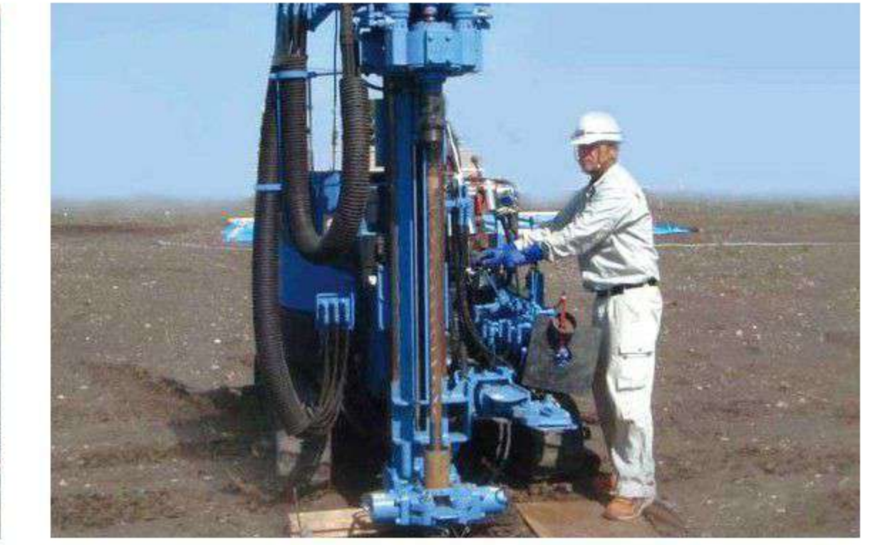
▲エコプローブによるボーリング調査状況
