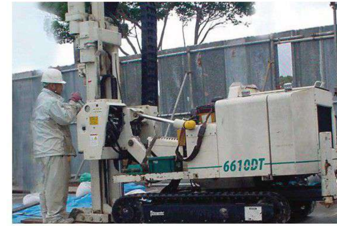
▲ジオプローブによるボーリング調査状況
