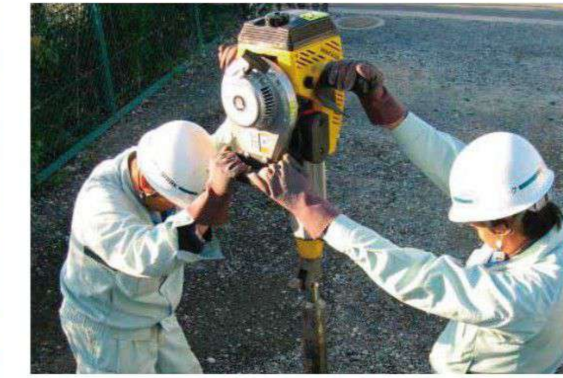
▲簡易式ボーリングマシンによるボーリング調査状況
